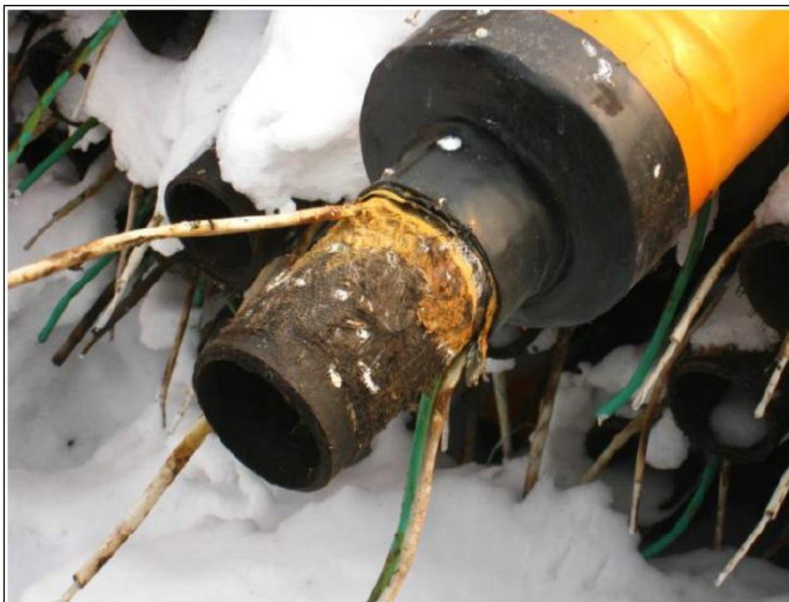
图 5.6 电加热管道中碳纤维三根并列式敷设
