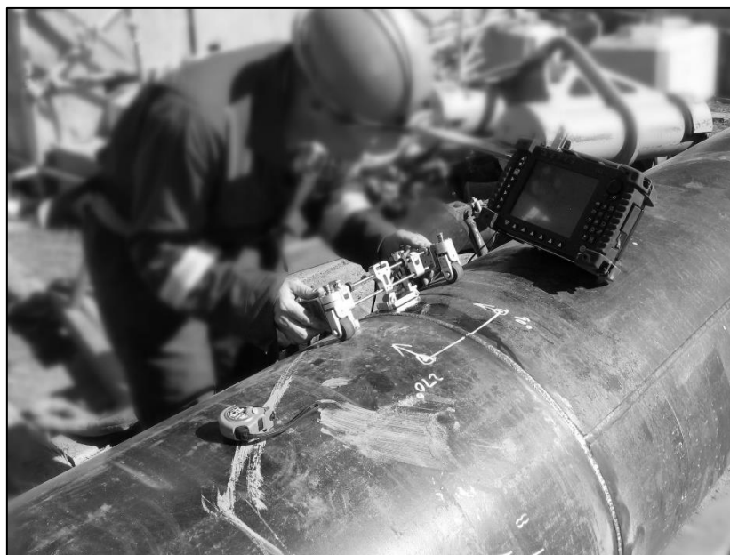
图 9.4 埋地管道超声导波检测图
